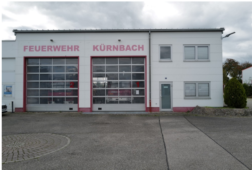
Abbildung 5 Feuerwehrhaus in der Gewerbestraße
